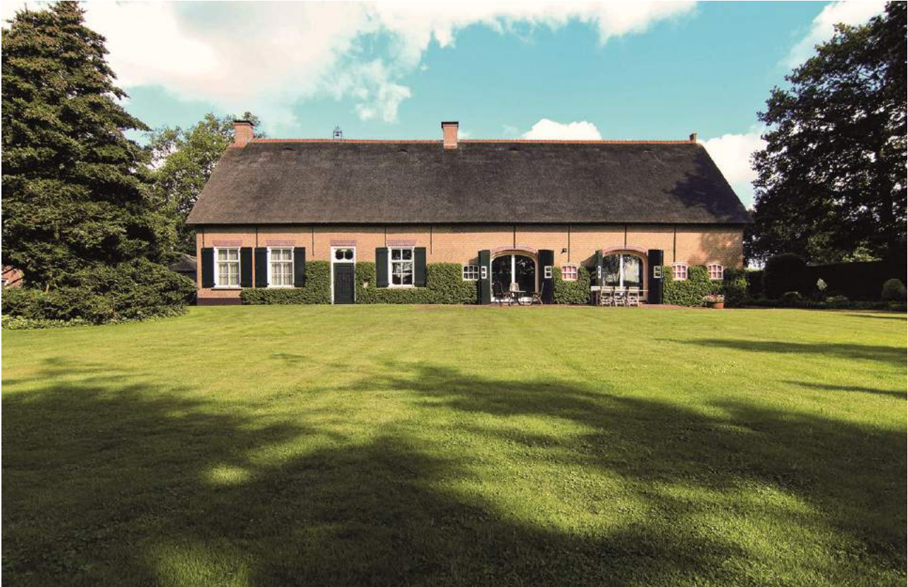
Groepszorg Woonboerderij, gezien vanaf de tuinzijde aan de Bredestraat
